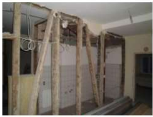
Vor dem Aufbau kommt der Abriss
