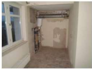
Vor dem Aufbau kommt der Abriss
