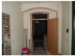
Vor dem Aufbau kommt der Abriss
