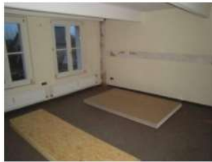
Vor dem Aufbau kommt der Abriss
