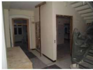
Vor dem Aufbau kommt der Abriss
