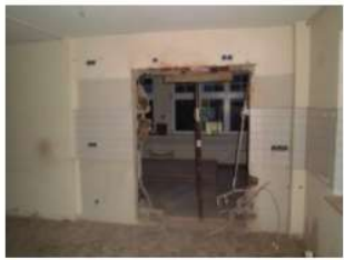
Vor dem Aufbau kommt der Abriss
