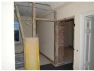
Vor dem Aufbau kommt der Abriss
