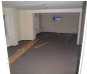
Vor dem Aufbau kommt der Abriss
