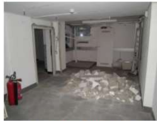
Vor dem Aufbau kommt der Abriss
