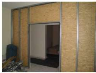
Vor dem Aufbau kommt der Abriss
