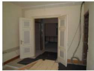
Vor dem Aufbau kommt der Abriss
